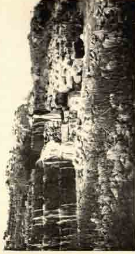
3 — Centre de la Digue, vu du Nord. Murs en gradins et ruines d'un contrefort. Sortie d'eau accidentelle dominant dans le Nahr el Asi.
