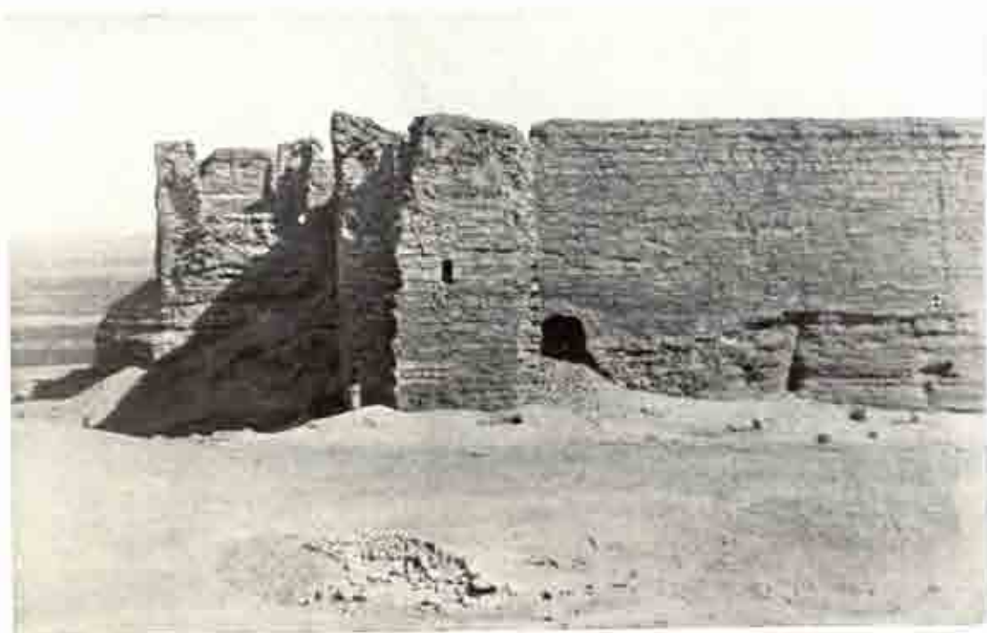
1. — Angle Nord-Ouest de la citadelle.
