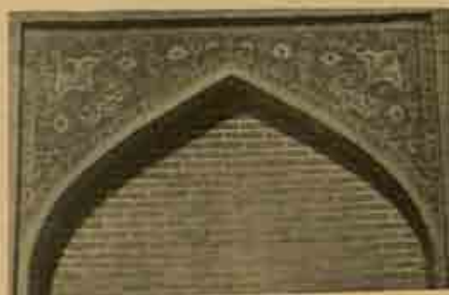
Fig. 306. — Arcades du pont de Bala Rock-éd-dia à Isfahan. Cliché : Garysis-Courtellemont.
