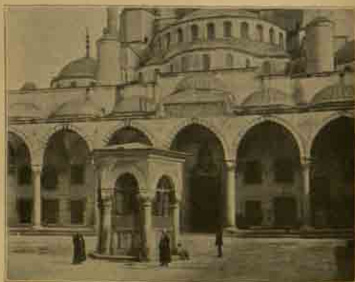
Fig. 386. — Cane et fontaine de la mosquée du sultan Ahmed I er à Constantinople.
