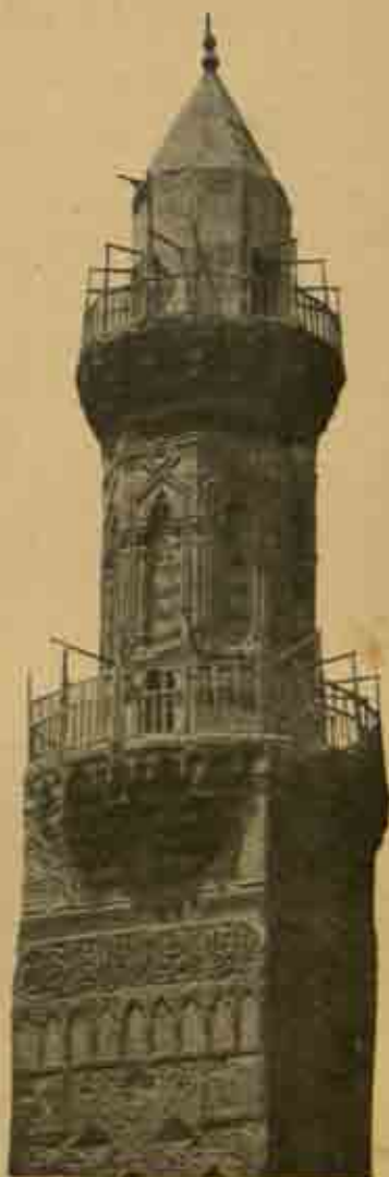
Fig. 58. — Minaret de la mosquée de Mohammed ben-Nasser au Caire; commencée 698 H. (1300 J.-C.). terminée 703 H. (1303 J.-C.) par Bilal-Ghazangir.
