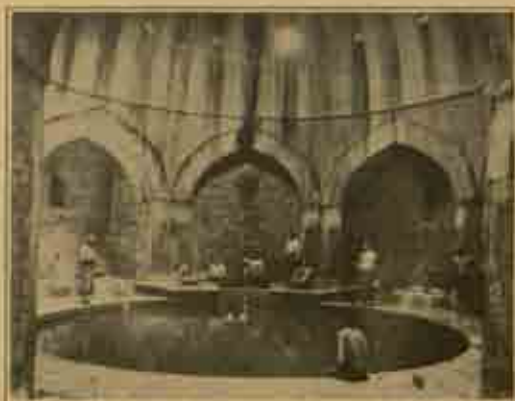
Fig. 303. — Intérieur des bains d'Yéchi-Kapilija à Bruxelles.
