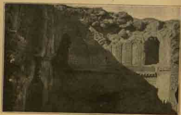
Fig. 122. — Détail d'un palais à Sedrata (Algérie) (utiches côtières servant de trompes aux angles de la table), x e siècle.
