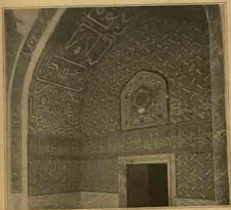
Fig. 279. — Entrée de Tchemli-kiosk à Constantinople.
