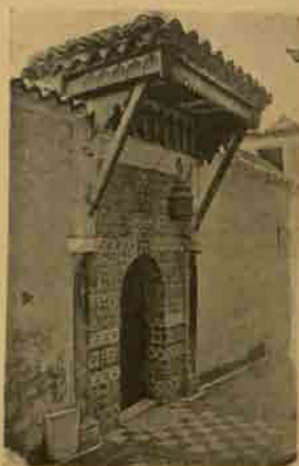
Fig. 119. — Porte latérale de Sidi Bou-Médine à Tlemcen, restaurée au XVII e siècle. — Clélie Gervais-Courtellemont.
