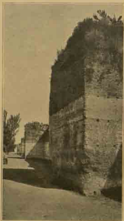
Fig. 146. — Murailles arabes de Cordoue. Les trous des boudins des coffrages qui ont servi à pilonner le pisé sont restés visibles.
