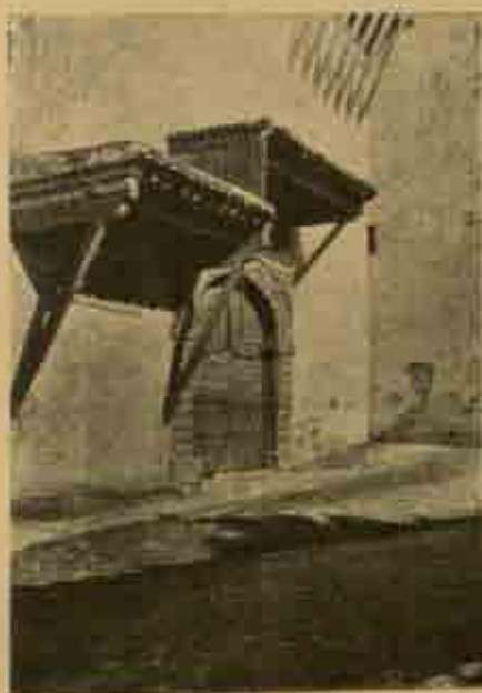
Fig. 213. — Portes dans la Casa à Alger. — Cliché Gervais-Gourtellement.
