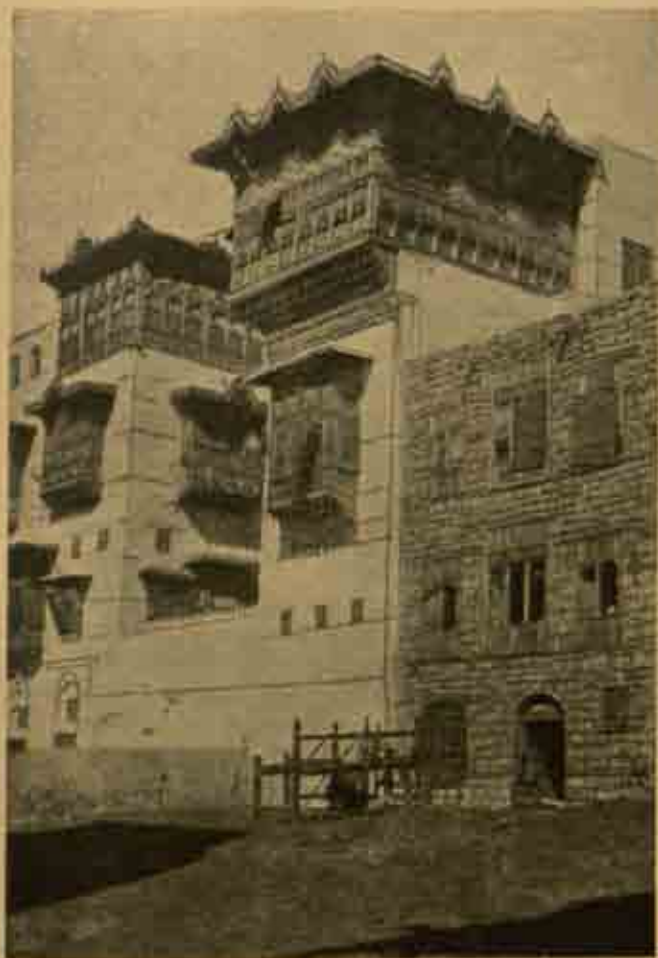
Fig. 127. — Maison à la Mecque. — Cliché Germain-Courtellemont.
