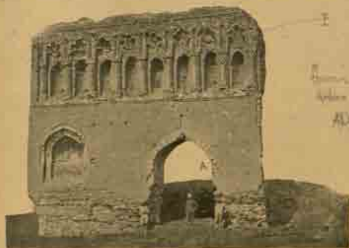
Fig. 251. — Ruines d'un palais à Bokha. — Cliché V. Chapot.
