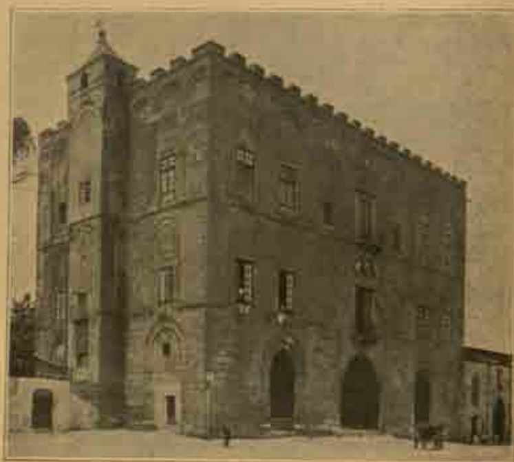
Fig. 171. — Façade de la Zisa, à Palerme (949 H.-1151 J.-C.).
