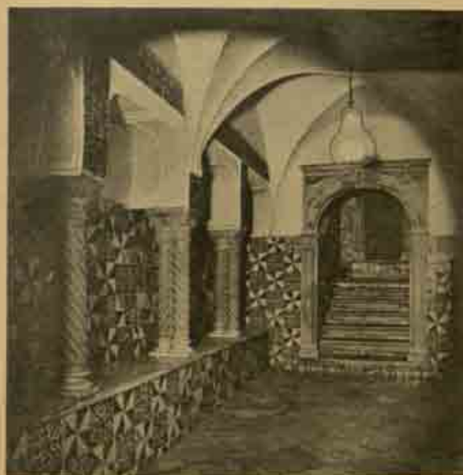
Fig. 215. — Vestibule du Conseil général à Alger. — Ensemble.
