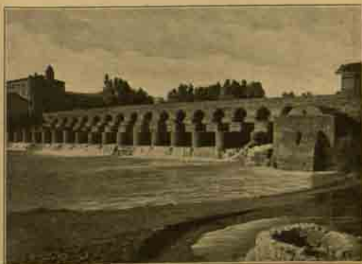
Fig. 231. — Pont et barrage de Téboursika, Tunisie.
