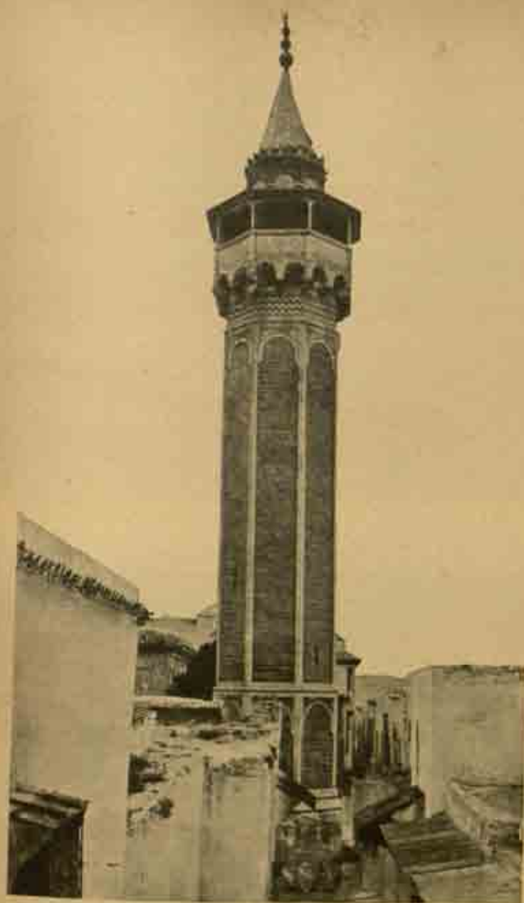
FIG. 228. — Minaret de la mosquée de Hamouda pacha, dit de Sidi-bey-Azoua à Tunis (1841-1842 H. 1275-1284 J.C.).
